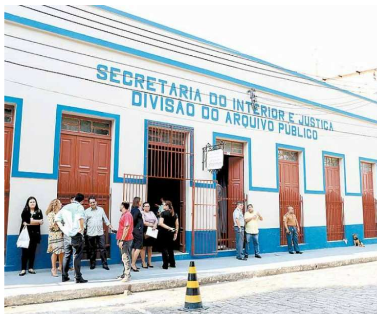
Figura 7 – Fachada do atual prédio onde funciona o APEAM
