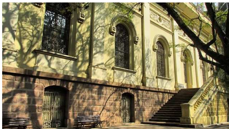
Figura 18 – Área interna do APERS.
