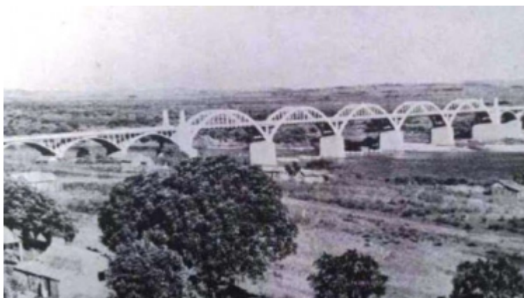
Fotografia 2 Ponte sobre o rio Ibicuí
